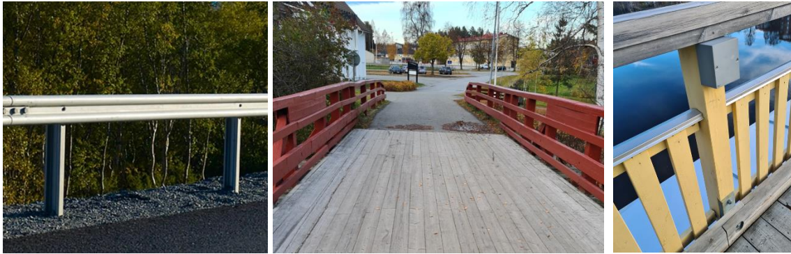
Figur 5 Väg räcke med Kohlsua-balk (vänster), gammal träbro i Bureå (mitten) och räcke till Älvsbackabron (höger)
